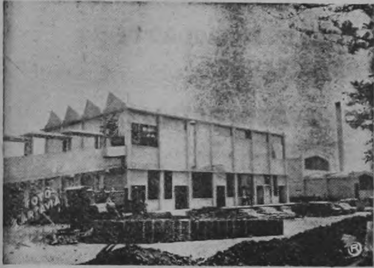
Vista parcial del Matadero de Montecillos en el cual ayer por la mañana se realizaron pruebas experimentales en el destace de ganado, con resultados magníficos, tanto en el aspecto técnico mecanizado como por las condiciones higiénicas modernas.
